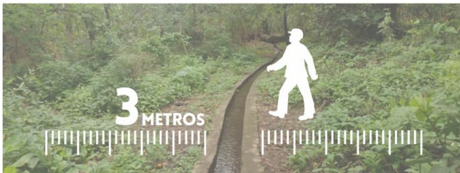
*Franjas de protección de al menos tres metros de longitud en ambos lados de un canal.*
