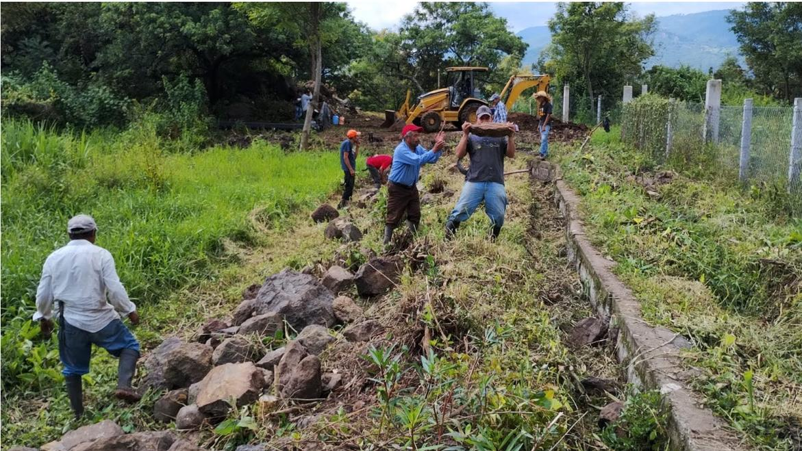
Faenas para la reubicación del canal "El Carrizal" y la generación de una brecha paralela.
