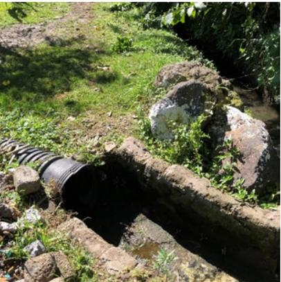
Primera canalización con revestimiento de cemento y uso de tubería.
